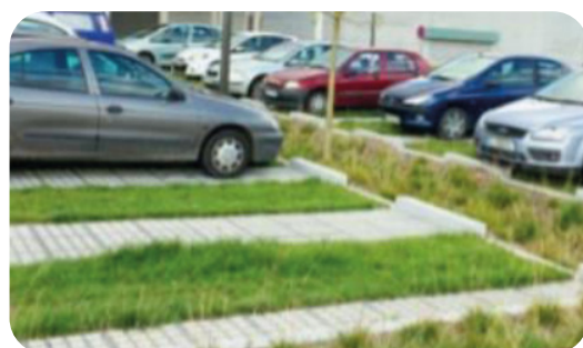
Noue végétalisée avec infiltration gravitaire du ruissellement
